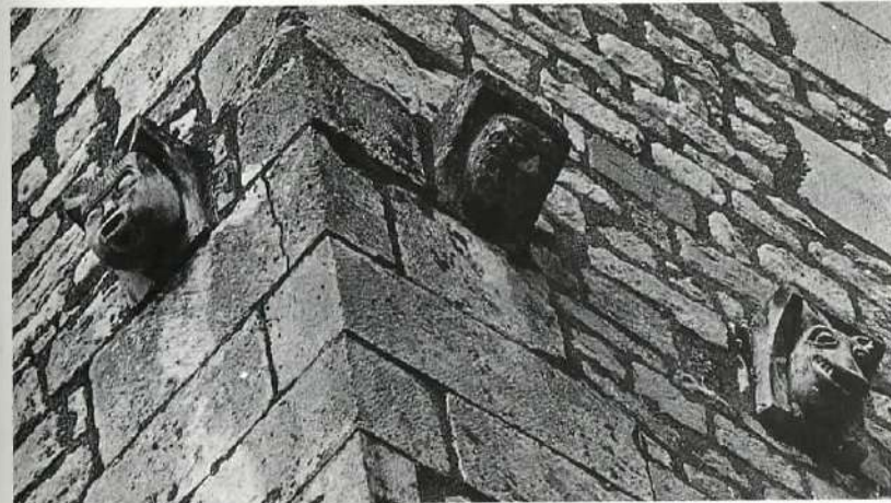
Détails : trois modillons de la tour-porche.
